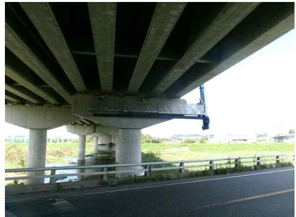
굴절점검차를 이용한 근접조사
