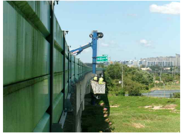
굴절점검차를 이용한 근접조사
