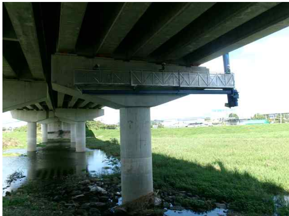
굴절점검차를 이용한 근접조사
